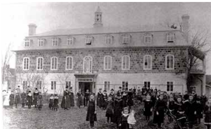
La plus ancienne image montrant le premier presbytère en entier, prise vers 1880 alors qu'il vient d'être exhaussé d'un étage plus un comble « à la française » à quatre pans.
