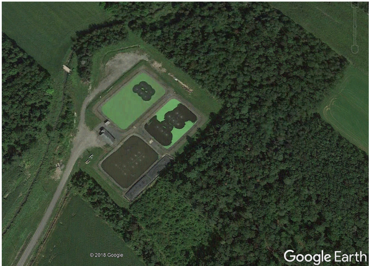
Figure 1 : Site des installations actuelles – Municipalité de Saint-Gervais
