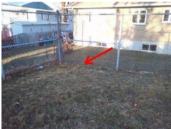
Espaces de plus de 100mm donnant accès à l'espace de jardin d'un service de garde.
