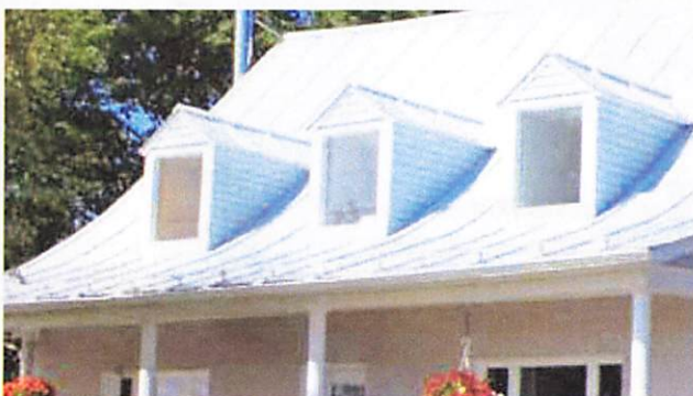
Figure 1: Exemples de l'assemblage, de la forme et de la couleur des matériaux de revêtement de toiture préconisés.
